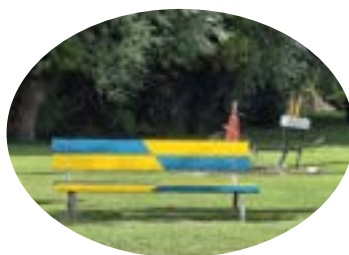
Réparation et mise en peinture du banc rue Roger Froissart
