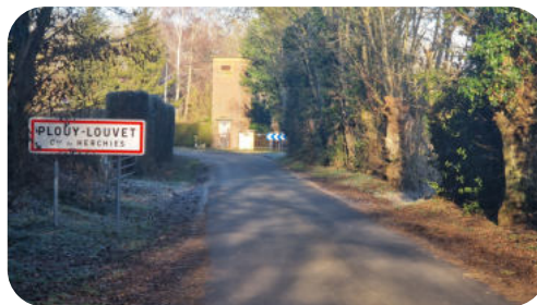
Réfection voirie au PLouy Louvet
