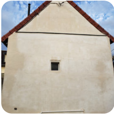
Pignon de la salle Annexe effectué par l'entreprise Scheidler d'Hémécourt.
