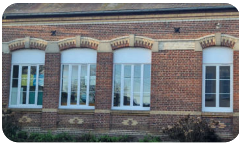
Rénovation des fenêtres de l'école de la classe CE2/CM1/Cm2 par l'entreprise Espace Fenêtre de Beauvais.
